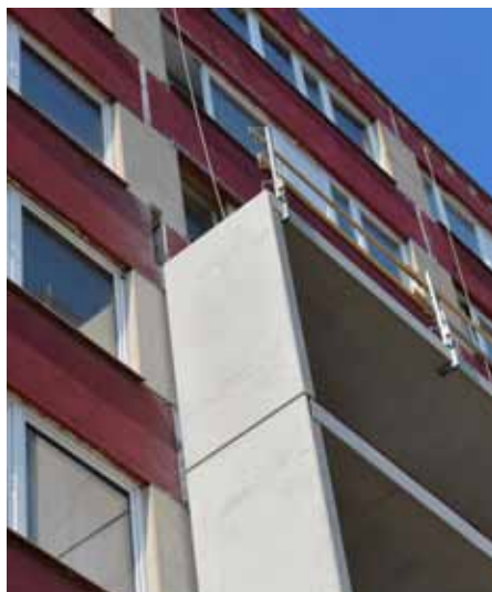
Panelový dům v Milánské ulici v Praze, stav před rekonstrukcí
