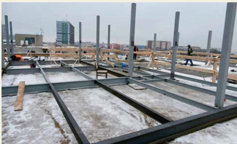
Ocelová konstrukce na střeše budovy pro poslední podlaží
