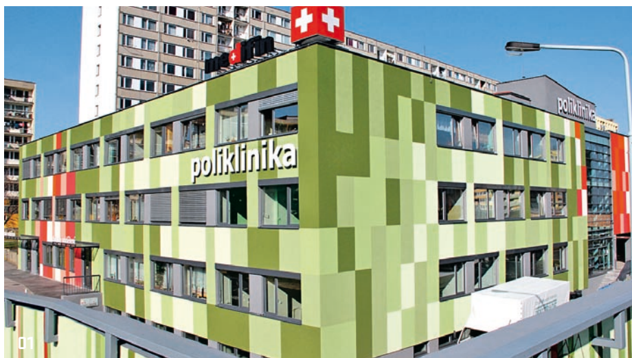
01 > Poliklinika Opatovská získala rekonstrukcí nový kabát a v soutěži Fasáda roku 2010 se umístila v kategorii Rekonstrukce zaslouženě na 3. místě
