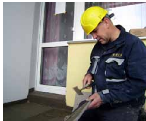
Pokládka dlažby na lodžii
