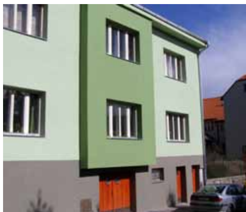
Rekonstruovaný bytový dům v Kokořínské ulici v Praze 8
