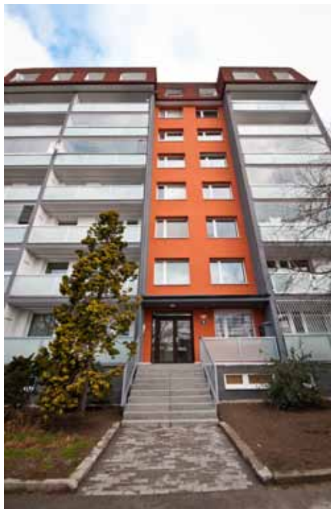
Panelový dům v Srbské ulici v Praze 10 po rekonstrukci. Architektonický návrh: Atelier P.H.A., s. r. o., Ing. arch. Ondřej Gattermayer Realizace: KASTEN, s. r. o.
