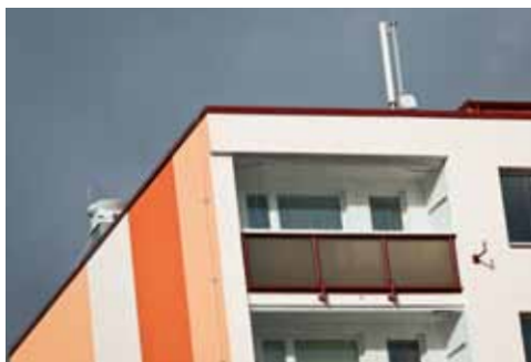
Detail lodžie rekonstruovaného panelového domu v Lindavské ulici v Praze 8. Architektonické řešení: A.W.A.L., s. r. o., Ing. Pavel Zídek Realizace: KASTEN, s. r. o.
